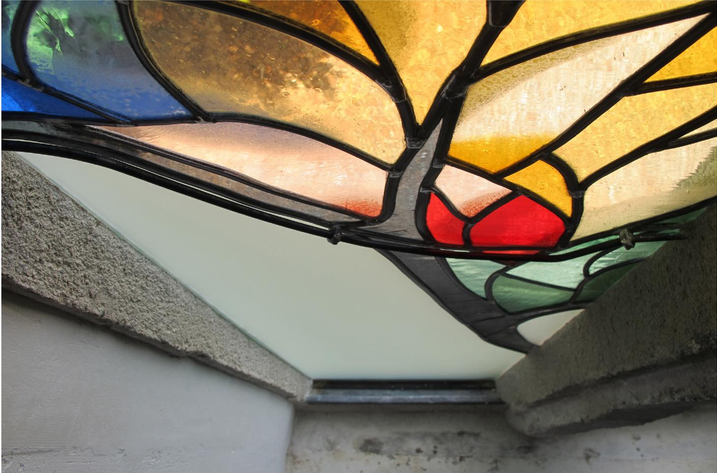
La techniques et les matériaux mis en œuvre sont respectueux du bâti ancien et conformes aux normes de restauration des Monuments Historiques. Pour limiter la portée du vitrail sur le meneau fragilisé par les siècles, une cornière en acier a été scellée.
